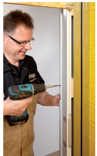
02 LOTRECHT & WAAGERECHT AUS- RICHTEN. ZARGE FIXIEREN.
