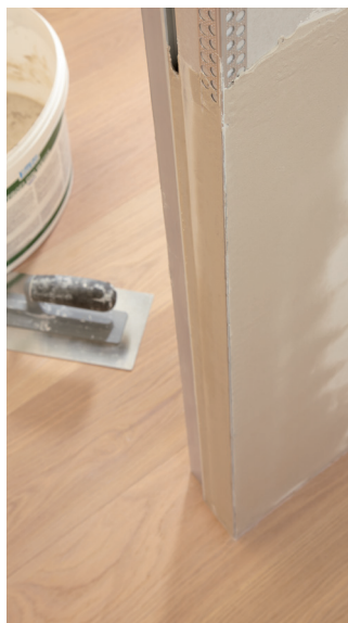
04 VERSPACHTELN MIT FASERVERSTÄRKTER SPACHTELMASSE
