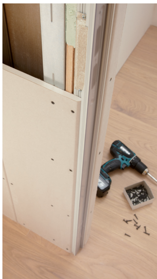
03 BEPLANKEN DES STÄNDERWERKES
