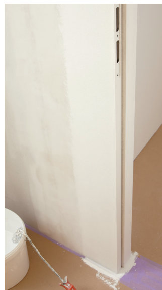
05 ANSTREICHEN DER WAND UND DER GRUNDIERTEN ZARGE
