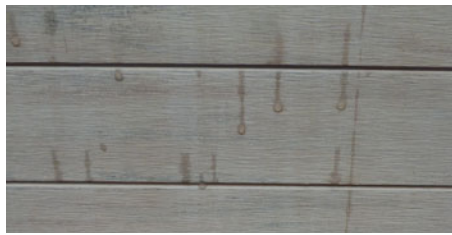
Fleckenbildung durch von Regen angelöste Partikel
