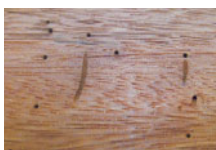
„Pinholes“ bei überseeischen Harthölzern
