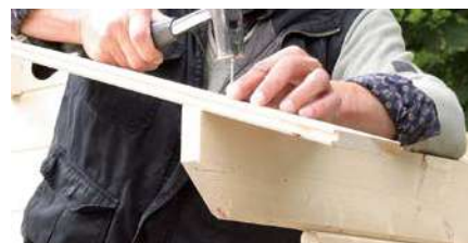
Abgeschrägte Seitenwandbohle
