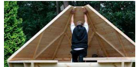
Vorgefertigte Dachelemente
