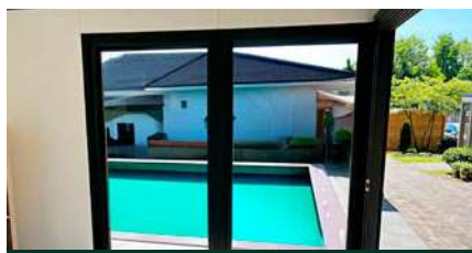
Isolierverglasung der Fenster und Türen
