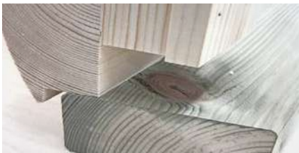
Wandelement auf imprägnierten Rahmen
