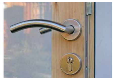
Edelstahl-Türbeschlag und Zylinderschloss
